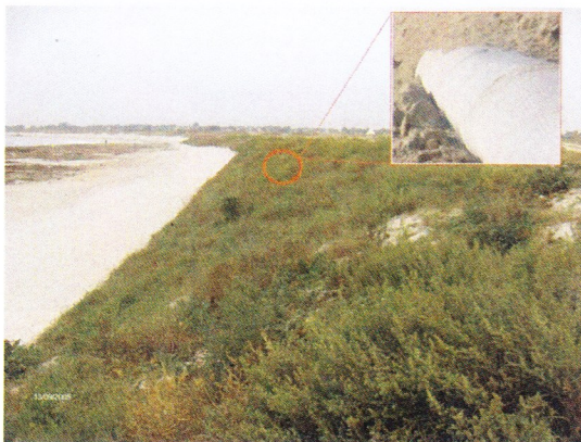
→ Photo du site de la Grève Blanche au Guilvinec (29) France STABIPLAGE® longitudinal de 145 mètres
