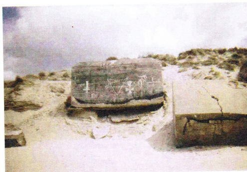
Photo de blockhaus du nord de la France
