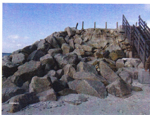
Photo Espace Pur – enrochement site de Cleut Rouz - Fouesnant (29) – France
