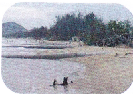
8 STABIPLAGE® conçus et posés sur site - Ete 2005
